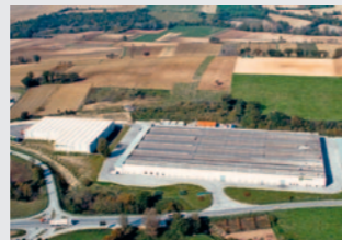
Faber S.p.A. Flaminia plant Fossato di Vico/Italy
