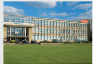
Franke UK Ltd Manchester/England
