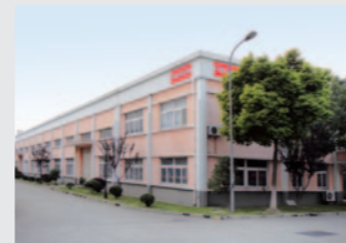
Franke Warehouse Shanghai/PRC
